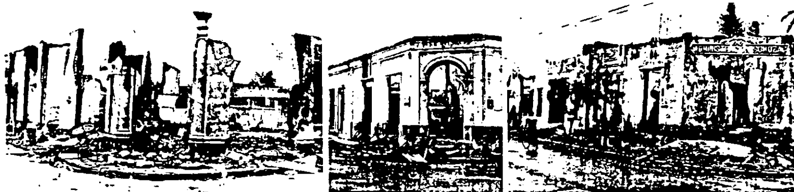
Estas graficas recogen crudamente la destruccion de Chinandega, despues de voraces incendios y constantes bombardeos. A la izquierda, aparece lo que fue el Edificio Seigelmann, al centro, el extremo oeste frente al Mercado Municipal, y a la derecha, el Palacio Departamental.
